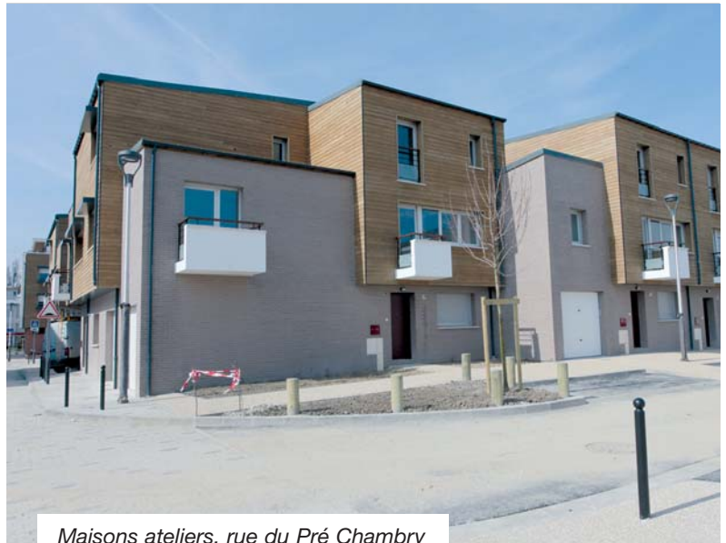
Maisons ateliers, rue du Pré Chambry
